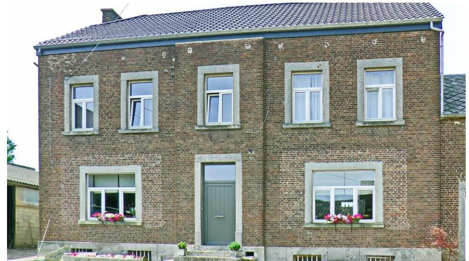
en tuiles. Le soubassement est en pierre calcaire et est percé de quatre jours de cave. Du côté droit, l'ancien fournil dont les baies rectangulaires en calcaire sont partiellement refaites est moins haut que le logis. Son toit en bâtière est couvert de carrés d'éternit.
