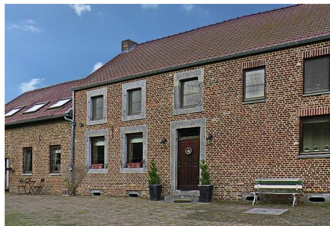
La maçonnerie est en briques et les baies rectangulaires sont en calcaire. Des jours de cave oblongs en calcaire sont bien visibles. La porte rectangulaire donne sur un perron d'une marche. Le toit est en tuiles rouges.
