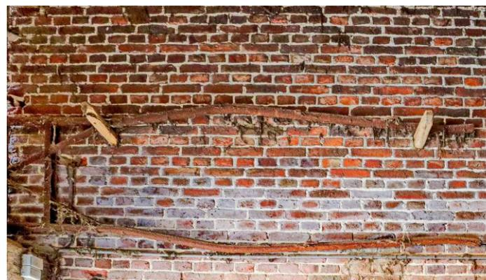
Sur le mur extérieur d'une étable, contre lequel se trouvait autrefois un hangar à matériel, il est possible d'encore observer des bois de charpente qui dépassent : ils servaient à y pendre les attelages.
