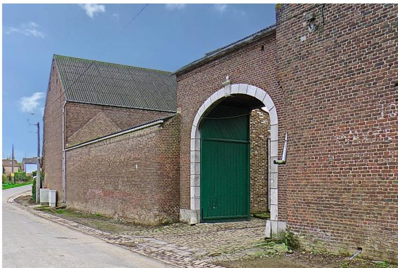
Le toit en bâtière du bâtiment était autrefois plus pentu qu'aujourd'hui : son profil est encore visible sur le mur de la grange. Le faîte a été abaissé et le toit est aujourd'hui recouvert de panneaux ondulés en éternit.
