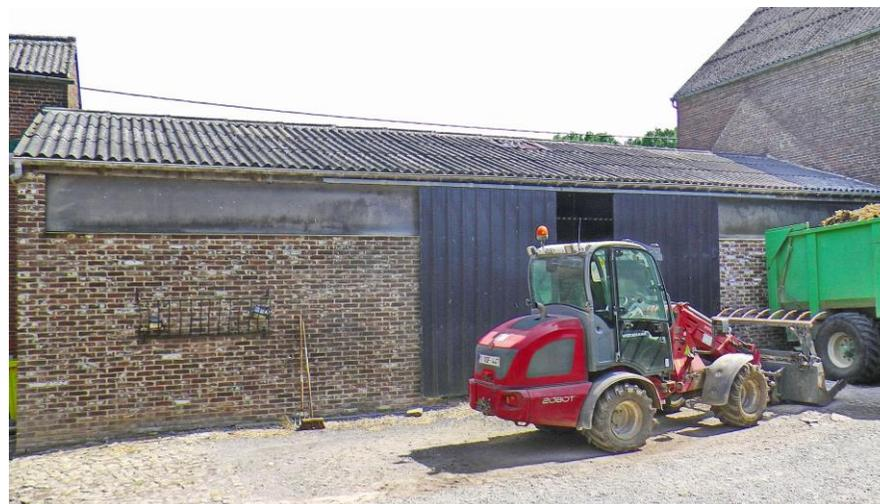
Au-delà, l'aile orientale est occupée par un vaste bâtiment rectangulaire sous un toit d'éternit : il abrite la grange en large, prolongée d'une étable. Les portails de la grange présentent des arcs de briques ; les pignons sont percés de trois oculi de briques.
