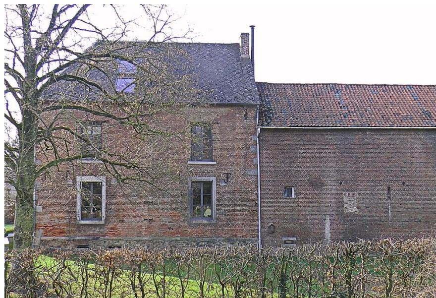
L'ancienne grange en double large occupe toute l'aile ouest de la ferme, à l'arrière des anciennes écuries. Elle est construite en briques et calcaire sous un toit en bâtière en carrés d'éternit. Les deux portails possèdent des arcs en anse de panier à claveaux passants un sur deux. Les murs sont percés de deux baies rectangulaires en calcaire.
