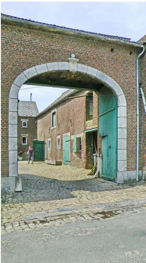
Côté cour, le linteau est en bois et est surmonté d'une entrée de colombier rectangulaire en calcaire. Actuellement, ce dernier n'abrite plus de pigeon. Le toit est couvert de panneaux ondulés en éternit.
