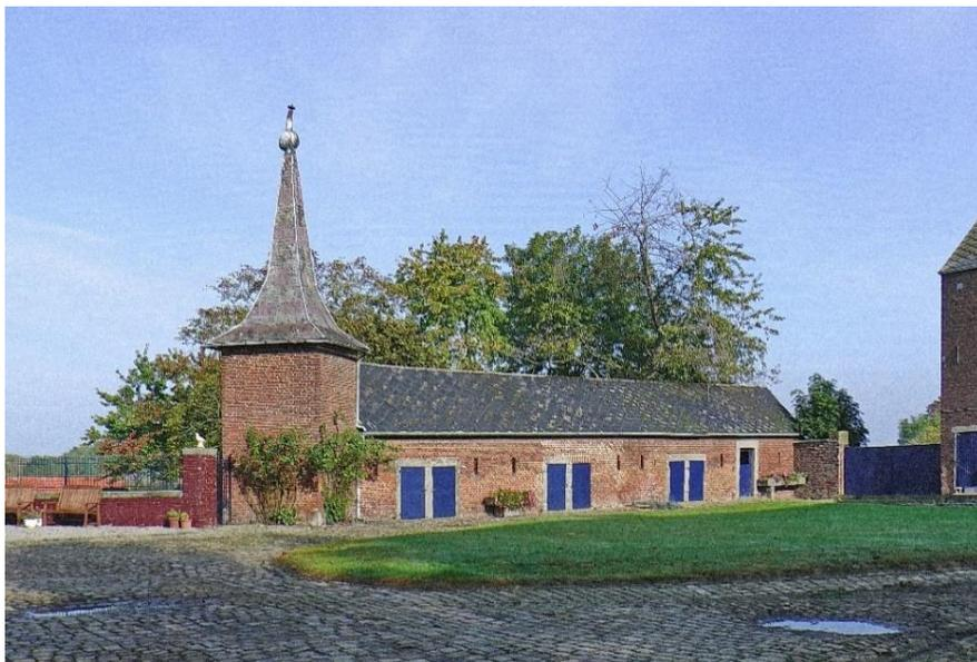
La cour est fermée par deux ailes perpendiculaires en briques et calcaire : une grange face au logis, des étables sous fenils le long de la rue. Les toits sont en plaques d'éternit. Des trous de boulins sont
