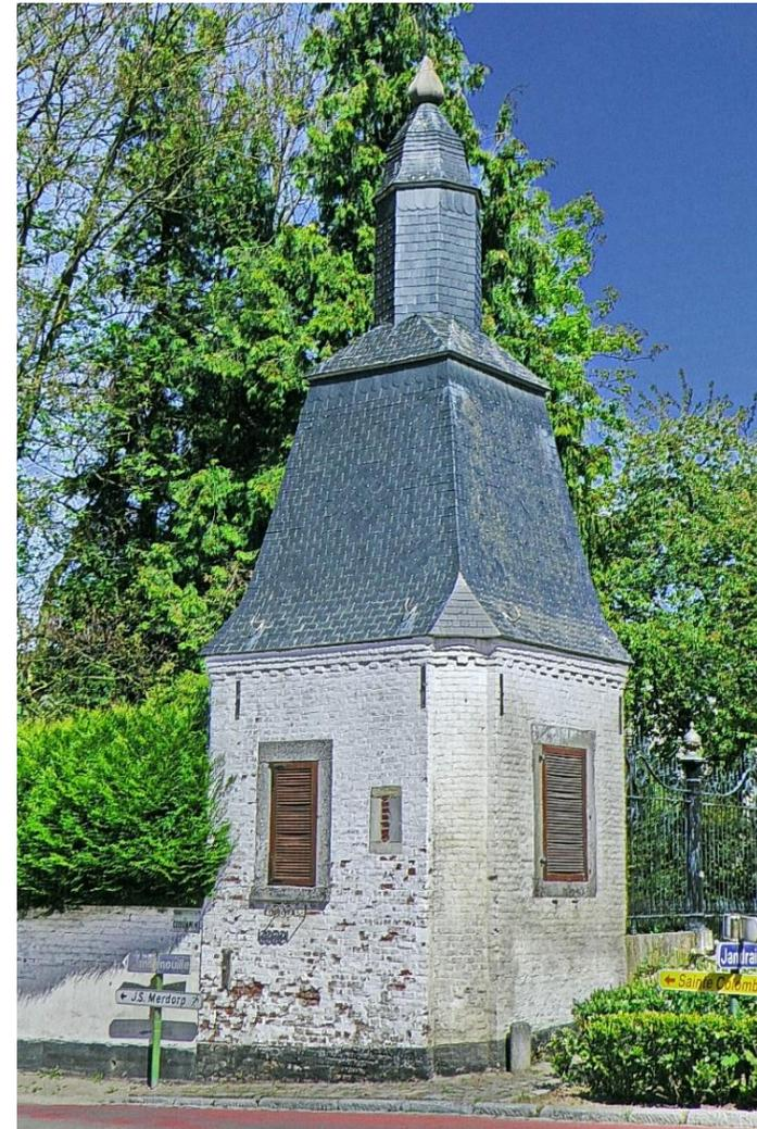
côté rues sont arrondis. Elle présente une belle frise de briques sous le toit en ardoises. Les percements sont rectangulaires et en pierres calcaires.
