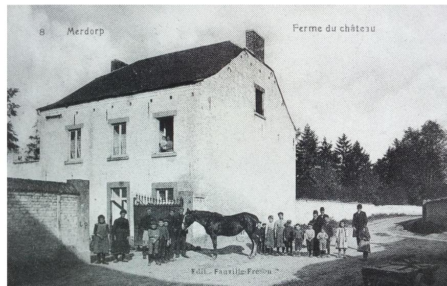
Côté cour, la façade du logis, en briques et pierres calcaires, comprend trois travées sur deux niveaux sous un toit en bâtière à croupettes. Si la porte rectangulaire en calcaire est typique de la fin du 18<sup>e</sup> siècle, les fenêtres du rez-de-chaussée sont plus contemporaines et leurs appuis ont été refaits. Les baies de l'étage ont aussi été modifiées. Côté jardin, le pignon porte le millésime 1784 (ou 1794 ?) sur une
