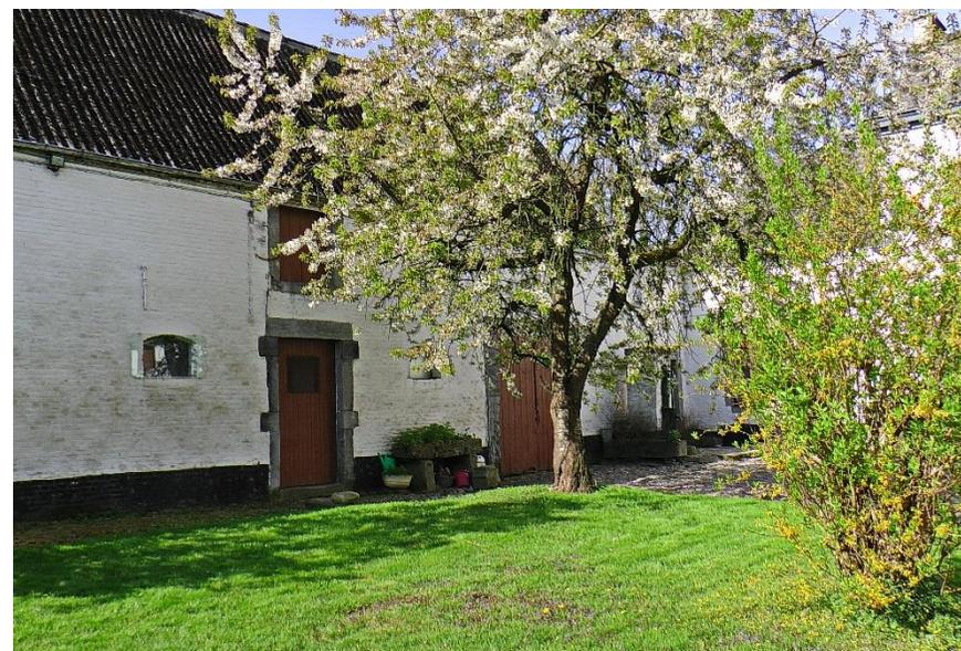
La partie proche du logis est occupée par une grange en large, ouverte d'un portail à linteau de bois. Dans la partie proche de la rue se trouvaient les anciennes écuries sous fenils. Les baies, partiellement modifiées, sont rectangulaires ; les piédroits sont constitués de plusieurs pierres calcaires. Côté rue, le pignon est percé d'une baie rectangulaire et d'un oculus de briques.
