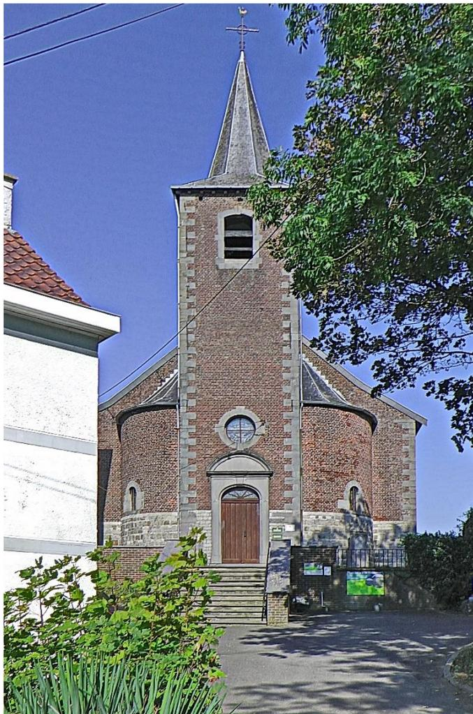
En façade, la tour carrée est renforcée de harpes d'angle en pierre calcaire. L'entrée axiale se fait par un portail en calcaire mouluré. Le linteau à clé en anse de panier est échancré. Il est surmonté d'un fronton cintré portant le millésime 1766 au tympan. Un œil-de-bœuf à quatre queues de pierre domine le tout.
