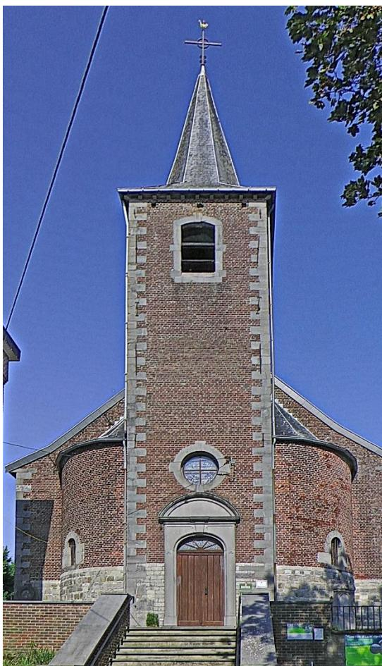
Le vaisseau est formé de trois nefs, de trois travées, limitées par des chaînes d'angle harpées vers l'avant. Les baies cintrées en calcaire, à clé, possèdent des piédroits à trois harpes. La pente du toit d'ardoises est moins forte du côté extérieur qu'au milieu
