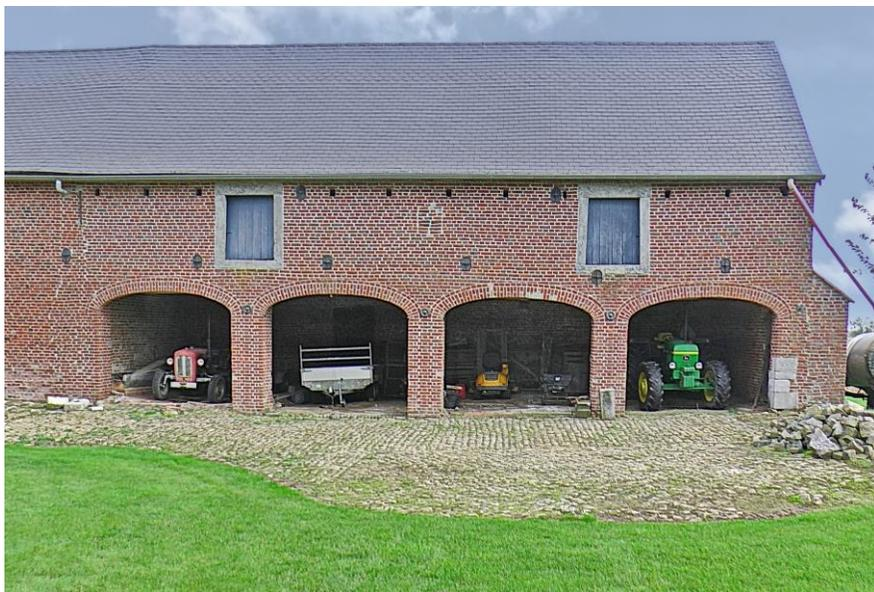
En 2017, le plafond des abris était encore constitué d'arcs maçonnés de briques sur chant reposant sur d'énormes poutres de chêne.
