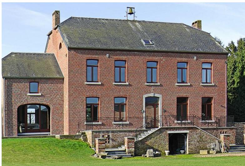
Il est formé de cinq travées sur deux niveaux, réparties symétriquement par rapport à la porte d'entrée, en pierre calcaire, comportant un linteau bombé à clé. Celle-ci est accessible depuis la cour par un double escalier en pierre bleue conduisant à une terrasse, encadrée d'une balustrade en fer forgé. Une annexe récente a été construite à gauche du logis par les époux *Reynaerts*. Les toits à croupettes couverts d'ardoises couronnent le bâtiment principal et l'annexe.
